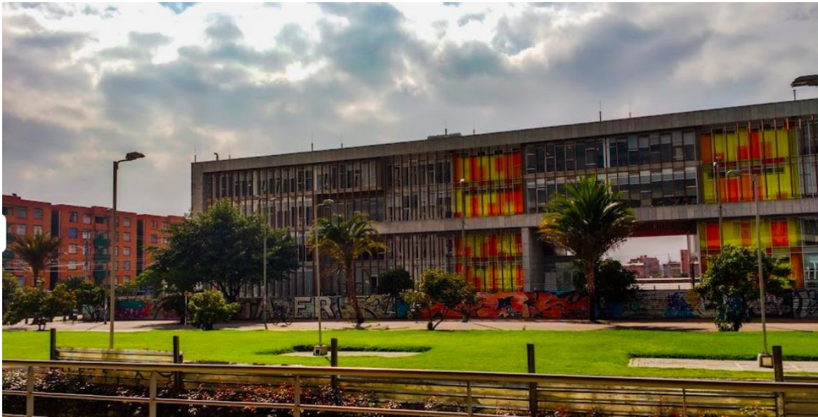
Ilustración 28. Instalaciones Sede Bosa Porvenir
