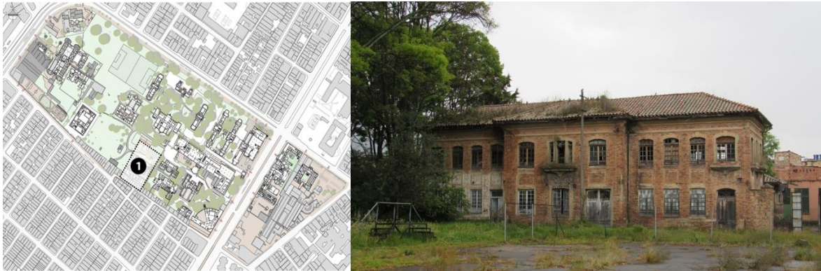
Ilustración 34. Complejo Hospitalario San Juan de Dios - CHSJD – Ed. Mantenimiento
