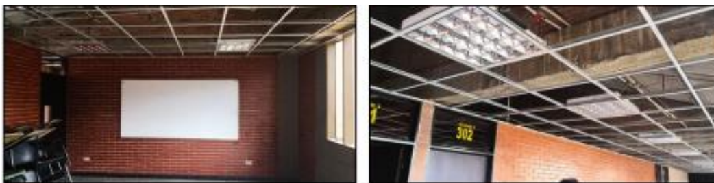
Ilustración 81. Registro Fotográfico - Proyecto Recuperación de cubiertas y baños Facultad Tecnológica Fuente: División de Recursos Físicos
