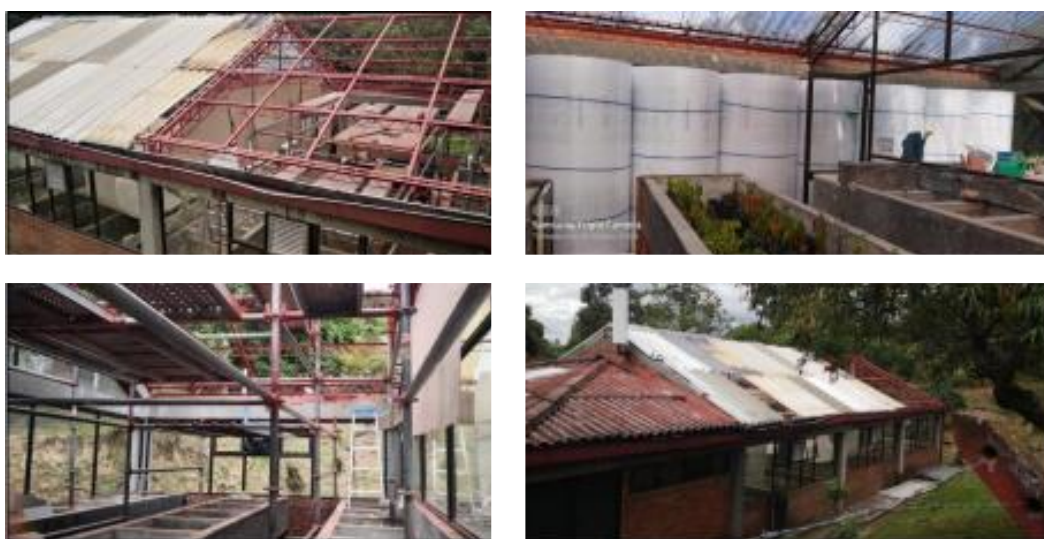
Ilustración 82. Registro Fotográfico - Proyecto Recuperación de cubiertas y baños Facultad Medio Ambiente Fuente: División de Recursos Físicos
