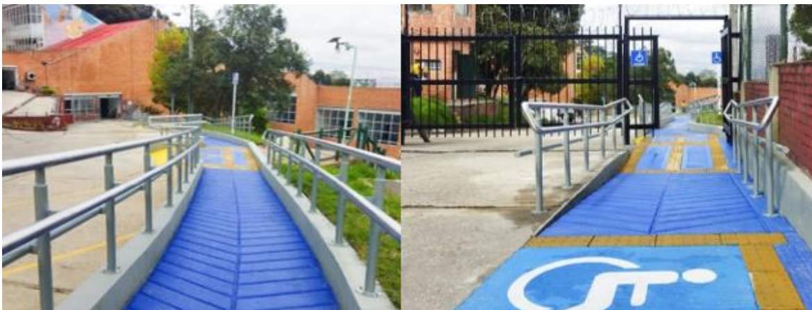
Ilustración 28. Adecuación Acceso Sede Macarena A por la Avenida Circunvalar
