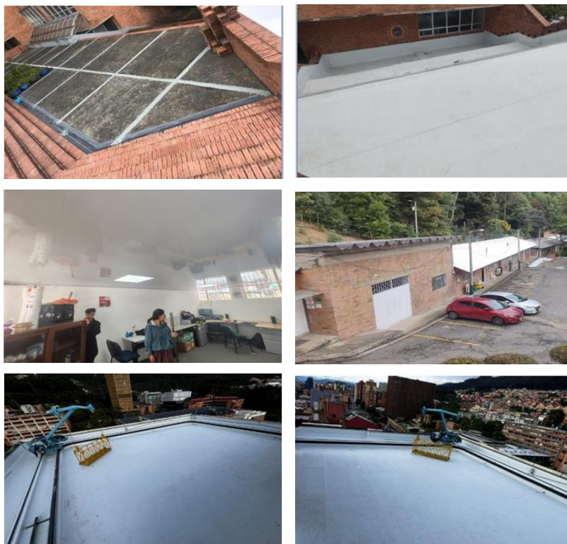
Ilustración 69 Registro fotográfico de las cubiertas Fuente: Oficina de Infraestructura
