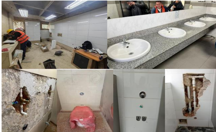
Ilustración 68. Registro fotográfico de las mejoras en las baterías de los baños Fuente: Oficina de Infraestructura
