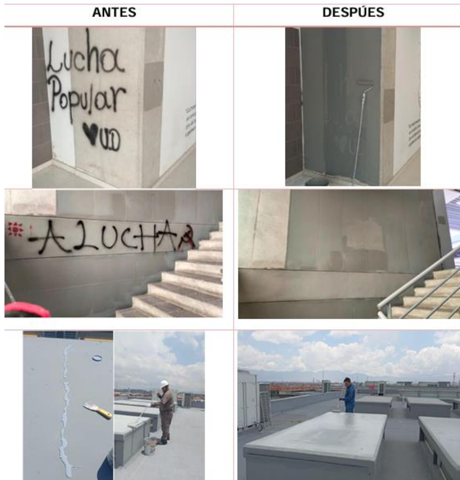
Ilustración 72 Intervenciones de Mantenimiento de la sede Bosa: Antes y Después Fuente: Oficina de Infraestructura
