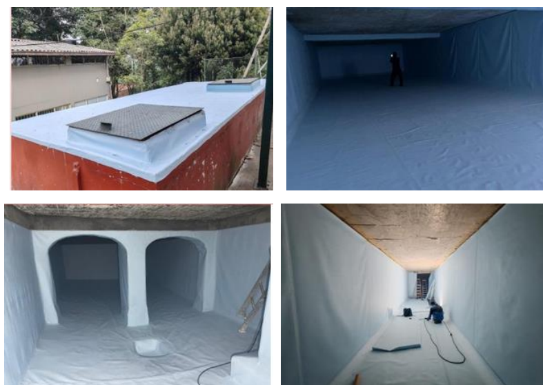
Ilustración 70 Registro fotográfico del mantenimiento realizado a los tanques Fuente: Oficina de Infraestructura
